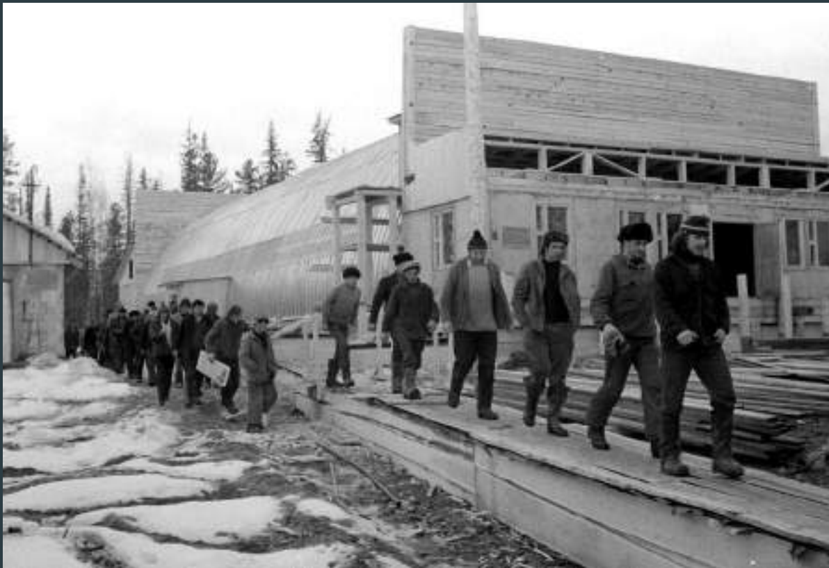
Строительство клуба п Кунерма. Впереди идет Володя Охонько
